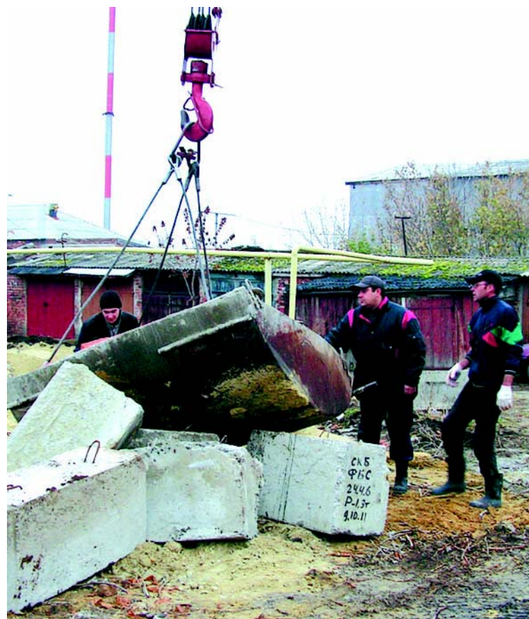
Без крана на стройке не обойтись.
